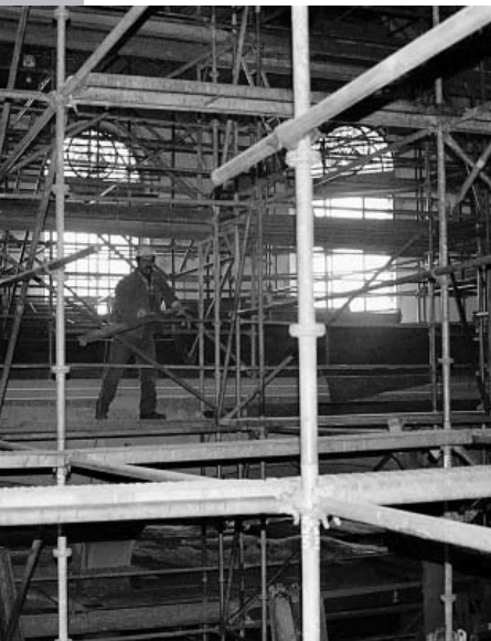
:: Gerüstbauer in der Peterskirche
